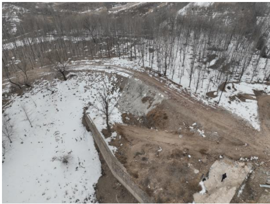
拟建1#施工区现状（部分）
